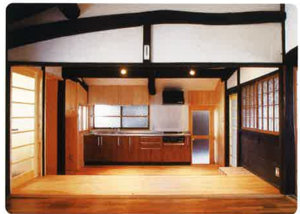
プリント合板仕上となっていた古い民家の台所・食堂を、軸組みを現しつつ、天井・垂れ壁を不燃材で仕上げ、防火性能を高めています。
