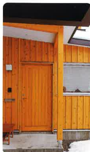
耐震改修と全面断熱改修を施した外壁の仕上げに、金属サイディングを用いています。道路から奥まった玄関に用いた板張りが親しみある印象を生んでいます。防火地域を除けば延焼の恐れのない部分、所定の防火措置を講じた部分は、板張りとする事も出来ます。（※写真：SUDOホーム/札幌市）
